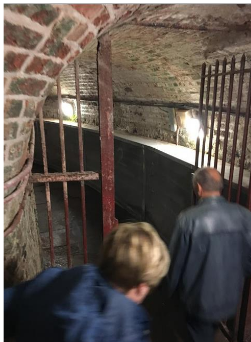
Billede 6 Tunnel mellem The Crumlin Road Gaol og domhuset; Foto: Ane Dolward
